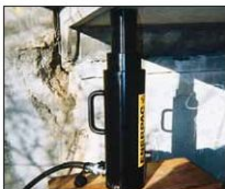
◀ Переносной цилиндр RACL-1506 со стопорной гайкой, используемый для удержания груза во время заливки эпоксидной смолы при укреплении моста.
