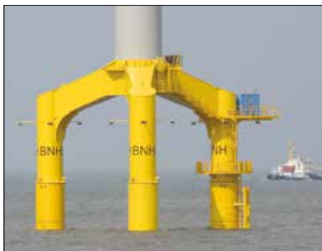
▲ Выравнивание морских ветроустановок: Система синхронного подъема Enerpac обеспечила выравнивание опор 80 ветрогенераторов.
